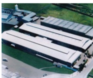
Fábrica em Guarulhos - SP
